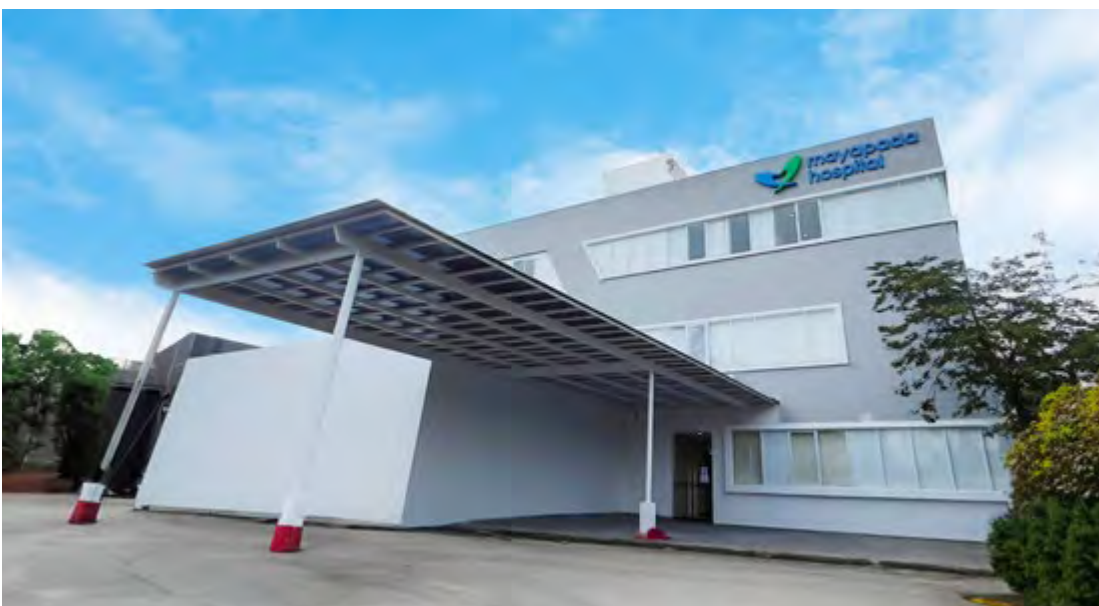
Salah satu gedung baru di Mayapada Hospital Bogor (MHBG) yang merupakan salah satu hasil dari proyek perluasan dan renovasi MHBG. One of the new buildings at Mayapada Hospital Bogor (MHBG) which is one of the results of the MHBG expansion and renovation project.
