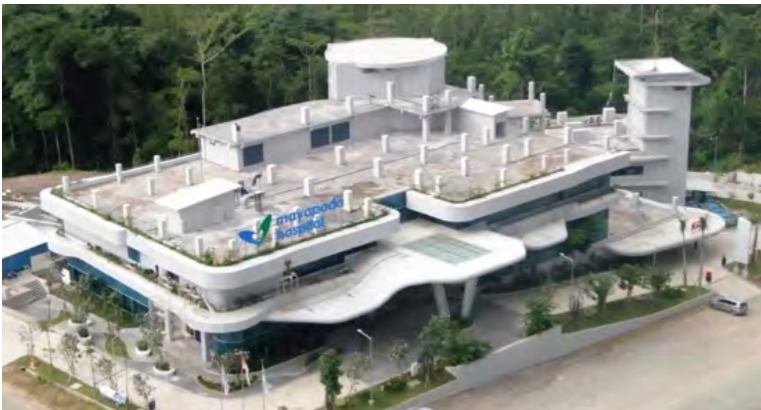
Proses penyelesaian Pembangunan Mayapada Hospital Nusantara (MHNS), di Ibukota Nusantara. The development completion process of Mayapada Hospital Nusantara (MHNS), in Ibukota Nusantara.
